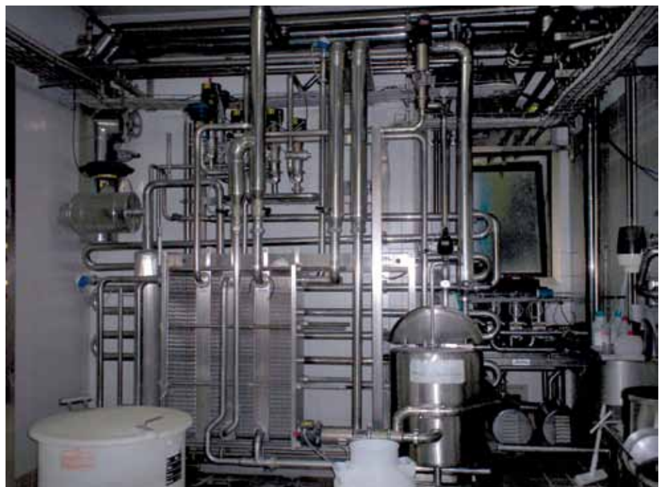
Caseificio Gaion Pasteuriser
